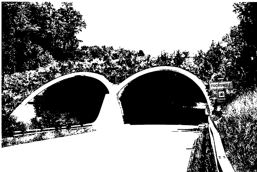
Fot. 6. Szwajcaria, Fuchswies. Nad autostradą N-7 zbudowano most-tunel, szeroki na 200 m. Przez tak zagospodarowany most, zwierzęta chętnie przechodzą. Powierzchnia mostu zrównana jest z poziomem lasu.
