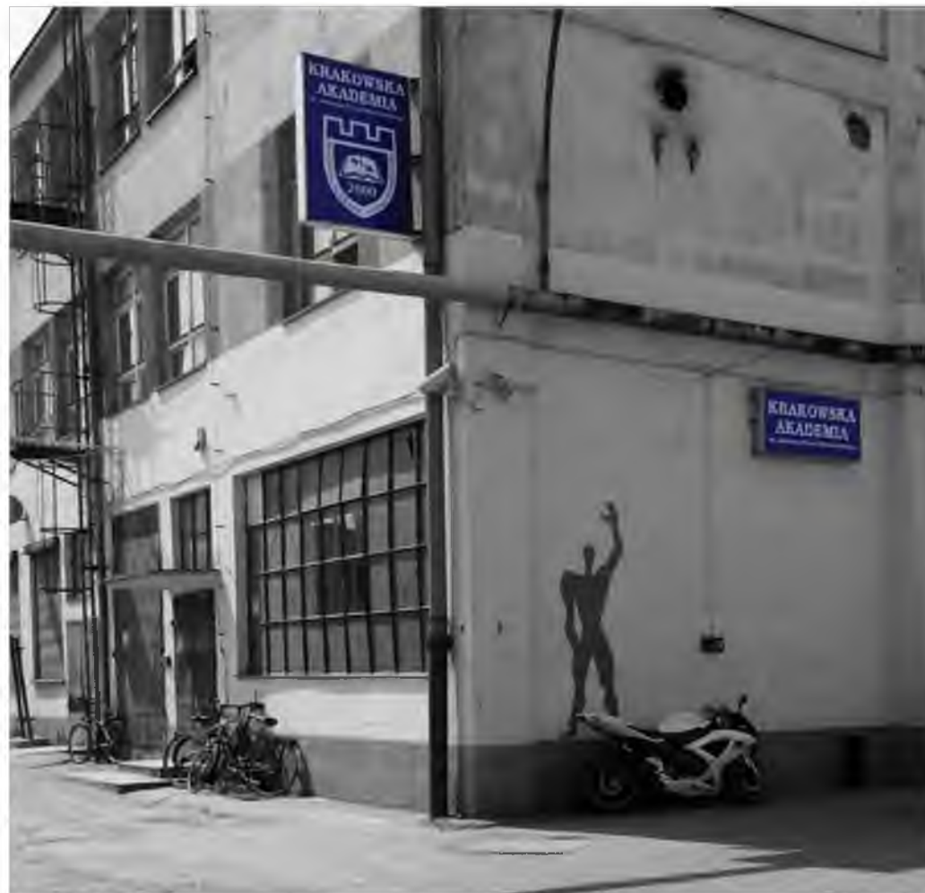
Budynek przy ul. Lipowej 4 – główna baza lokalowa Wydziału Architektury i Sztuk Pięknych
