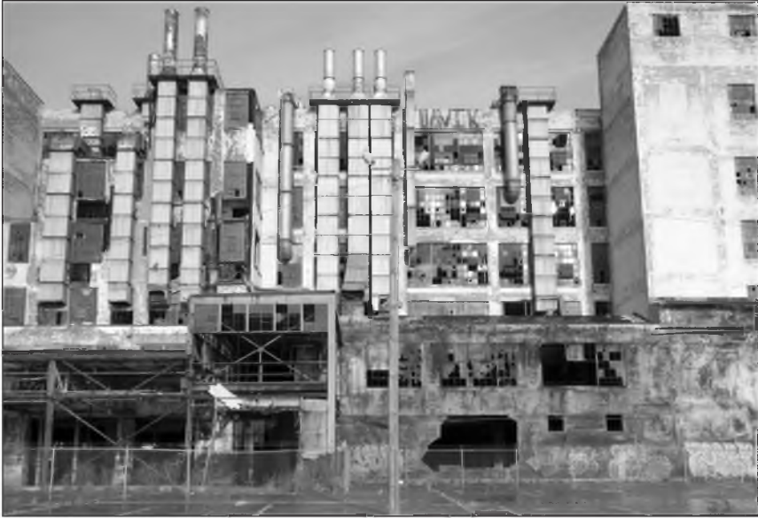
Fot.7. Fragment zdewastowanej hali produkcyjnej Packard Factory .
